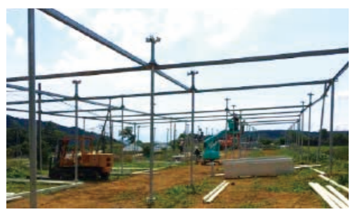
静岡県で建設中の大規模ソーラーシェアリングの架台。他社の太陽光発電設備の倒壊事故があった町で、ソーラーシェアリングには後ろ向きな地域だったが、翔栄クリエイトの実績が評価され、建設にこぎつけた。
